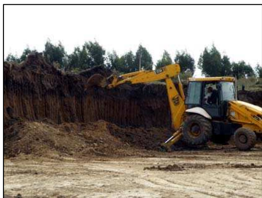
Foto 28: Extracción con retroexcavadora.
